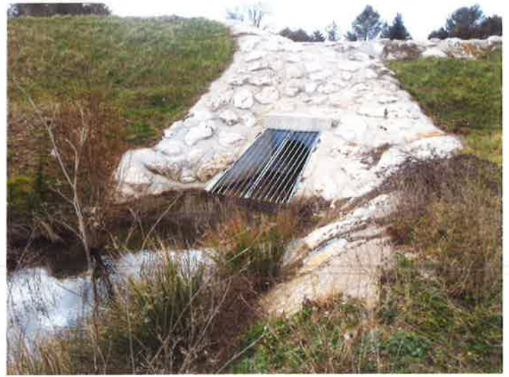
Mise en œuvre d'ouvrage anti embâcle autour duquel un dispositif anti affouillement a été réalisé au moyen d'enrochement maçonné. Pas de désordre constaté
