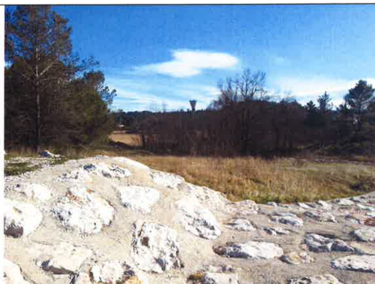
Dispositif antiaffouillement aux extrémités du déversoir
