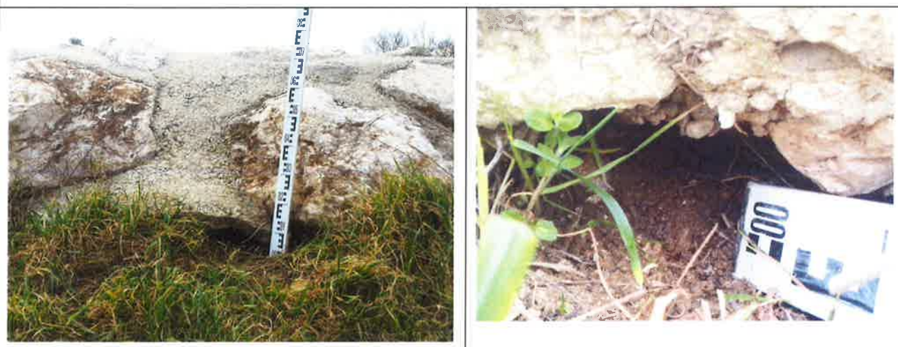
Présence de vide sous l'enrochement visible en talus amont
