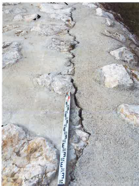
Vue depuis la partie sommitale, on note l'extrémité amont de la carapace en enrochement se désolidarise
