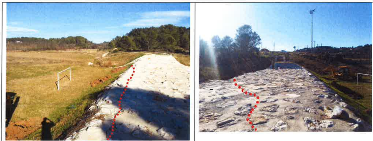
Fissurations transversales et longitudinales
