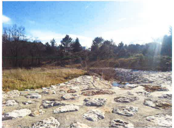
Vue sur ouvrage dissipateur d'énergie d'écoulement des eaux – Pas de désordre constaté.
