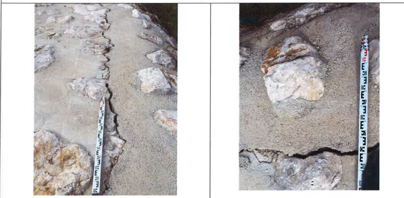
Fissuration longitudinale en crête de talus amont (3cm)
