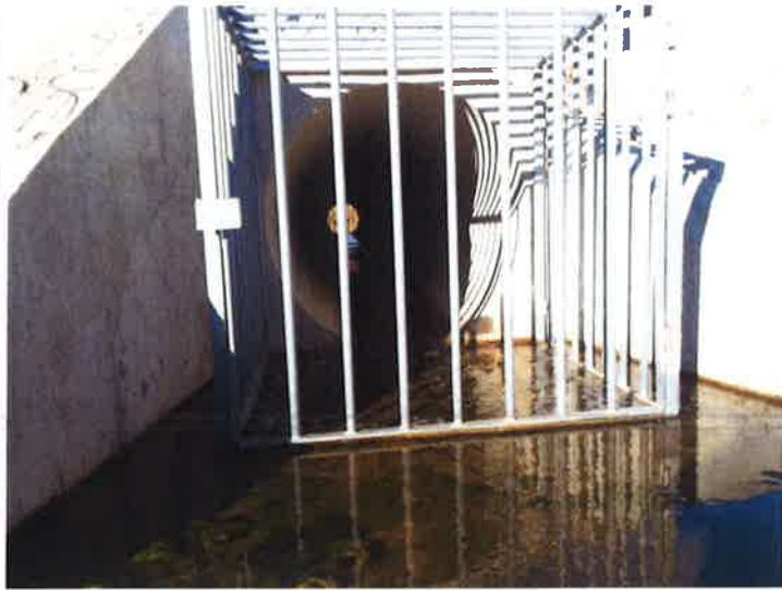
Mise en œuvre d'ouvrage anti embâcle autour duquel un dispositif anti affouillement a été réalisé au moyen d'enrochement maçonné. Pas de désordre constaté
