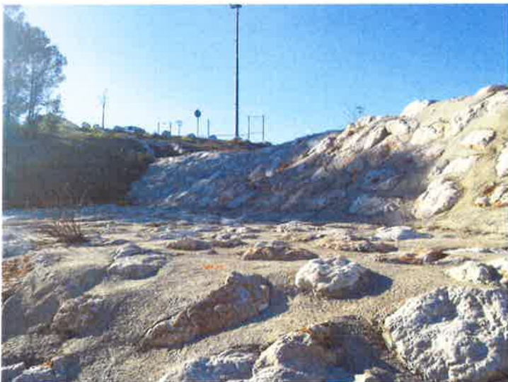
Vue depuis l'aval sur enrochement de recouvrement du talus. Pas désordre visible sur cette partie
